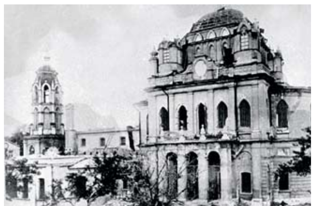
Начало разрушения Богородице-Рождественского собора монастыря, 1933–1934 гг.
